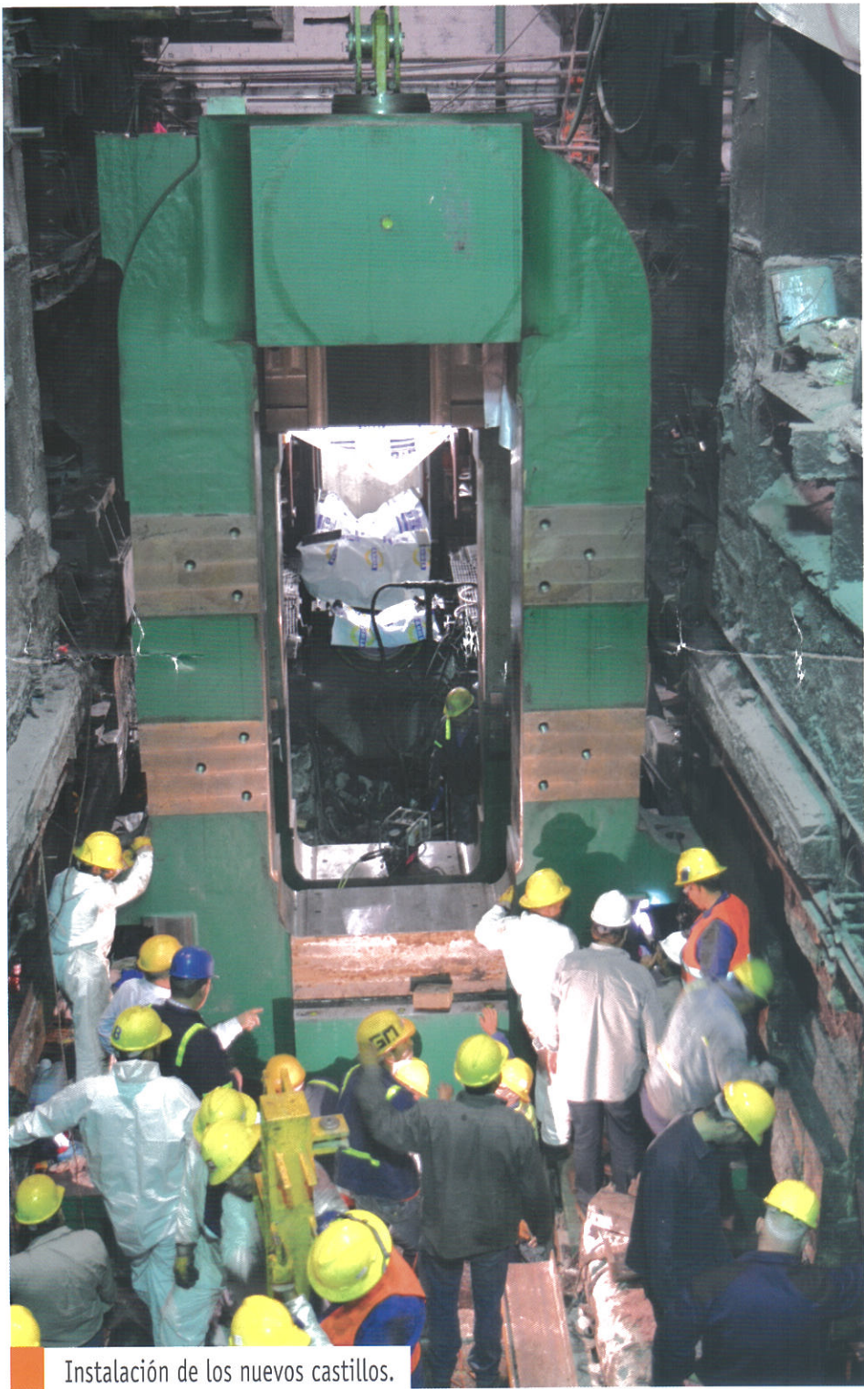
Instalación de los nuevos castillos.
